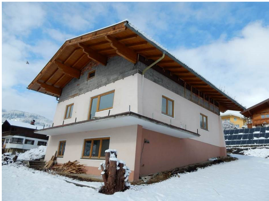
Abbildung 8: Haus A in der Vorbereitungsphase des Abbruchs
