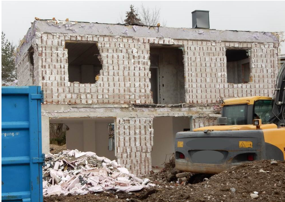
Abbildung 9: Haus B zum Zeitpunkt der Erstbegehung
