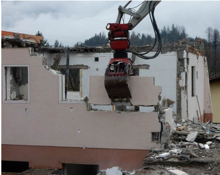
Abbildung 10: Abgreifen der Holzspanbeton- Außenwand
